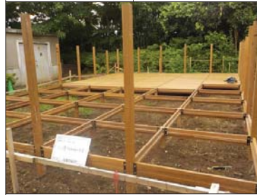
フレーム取付完成
