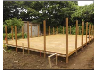
デッキ床面 完成
