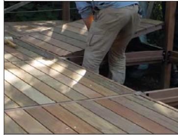
パネルのはめ込み
