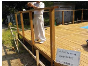
フェンス笠木の取付
