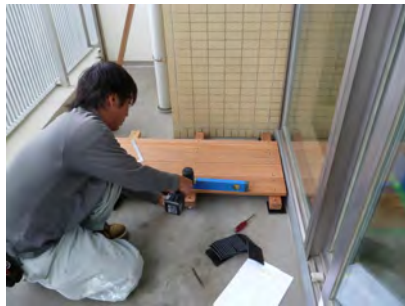
水平にしてサッシとの高さを調整
