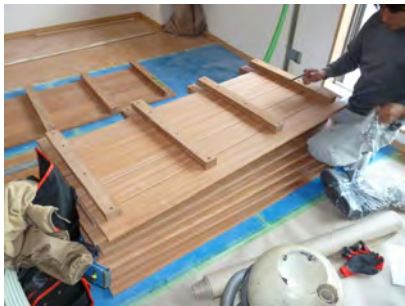
パネルにしたデッキにアジャスターを付ける
